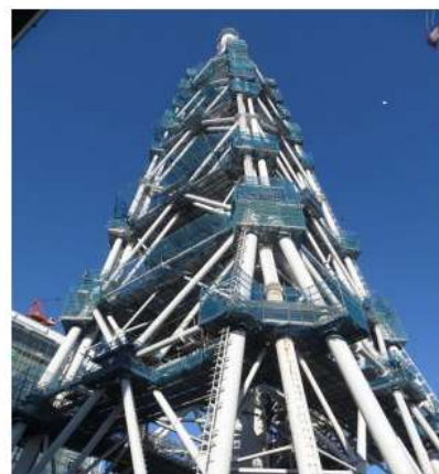
主排気筒耐震補強工事 の状況
