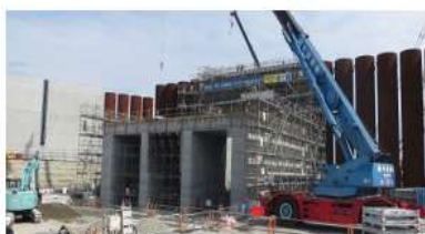
防潮堤設置工事 の状況
