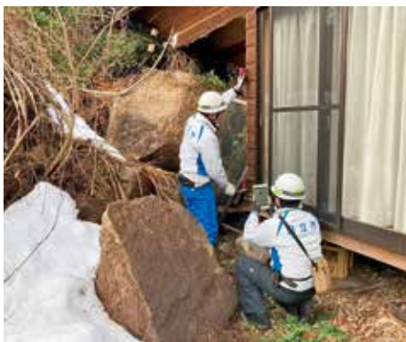
被災した建物の被害認定調査
